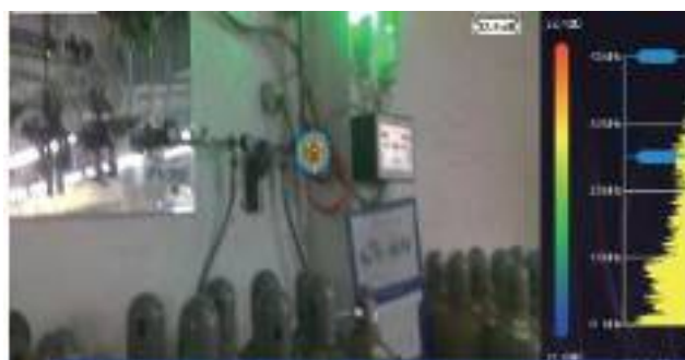
空调行业-氮气泄漏
