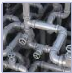
气体泄漏监测
